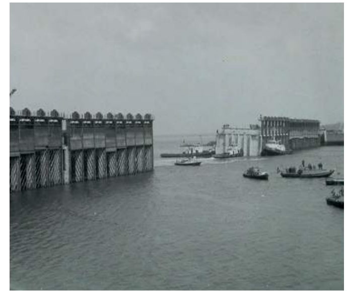
Bouw van de Veersegatdam, foto: https://beeldbank.rws.nl , Rijkswaterstaat
