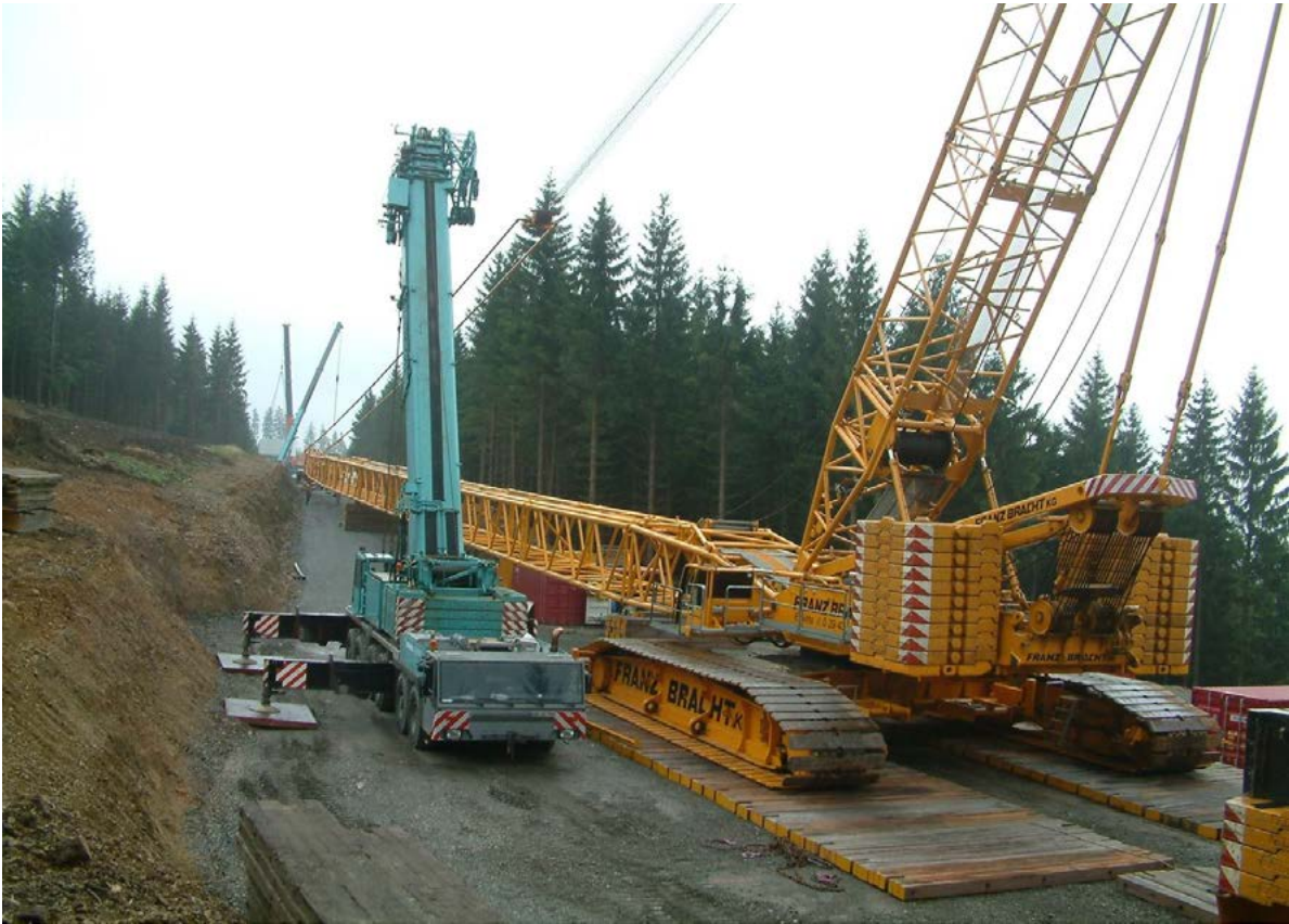
Fig. 2 – Er is voldoende ruimte nodig om de enorme kranen in te kunnen zetten de windmolen op te bouwen (foto: Günter Pulte, RothaarWind)
