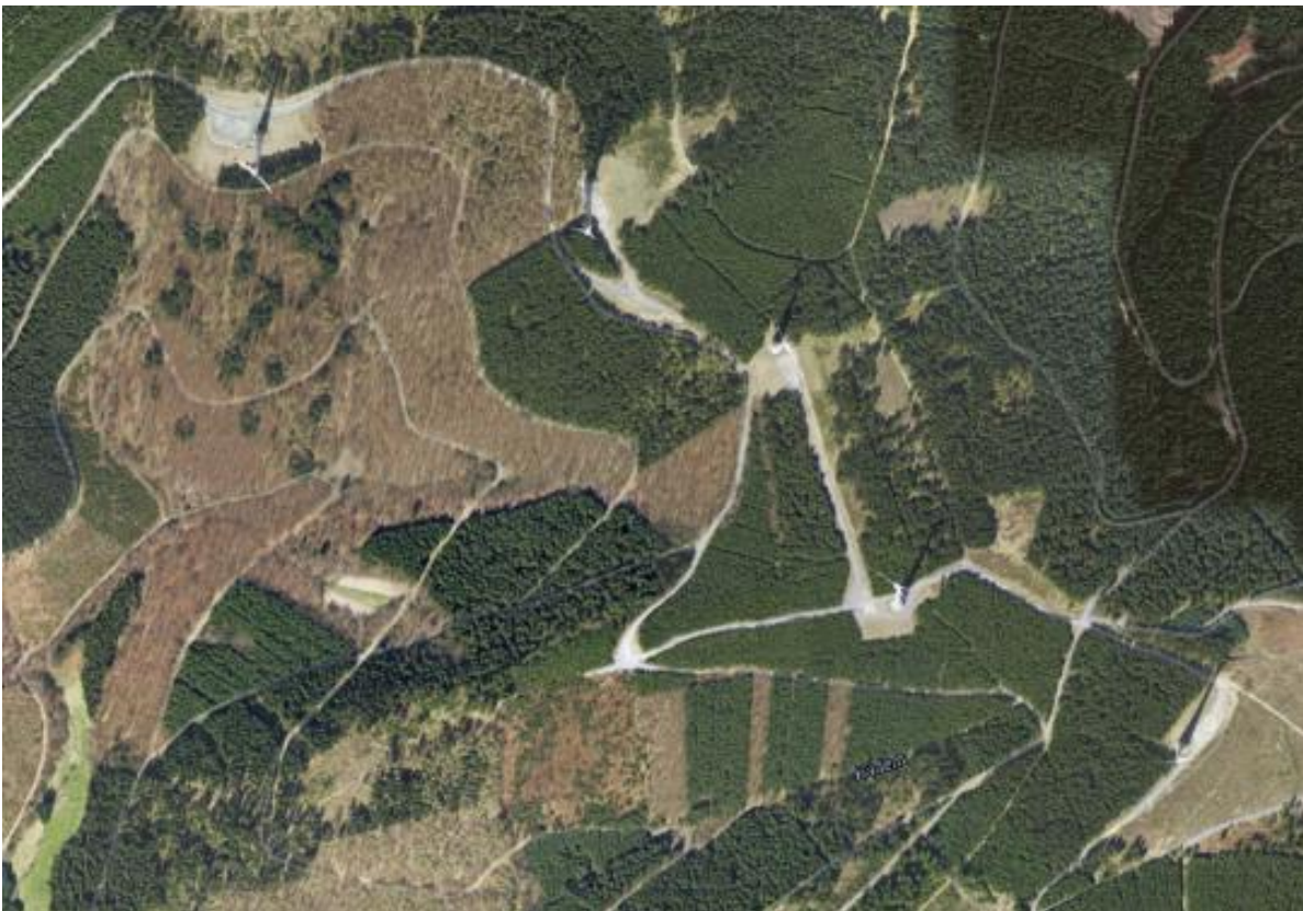
Fig. 1 - De vijf windmolens van windpark Hilchenbach, net ten noorden van de plaats Hilchenbach (bron: GoogleEarth, 2015).
