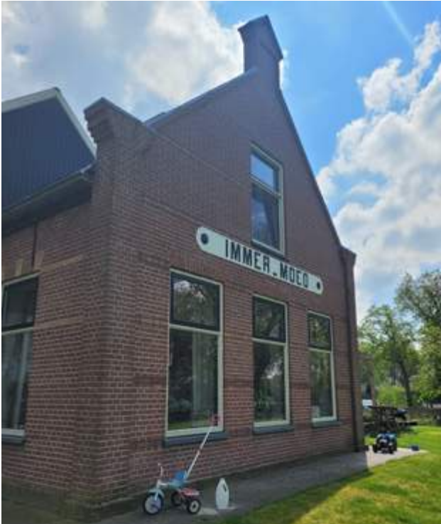
Gevel hersteld monumentale hoeve, nu als woonhuis
