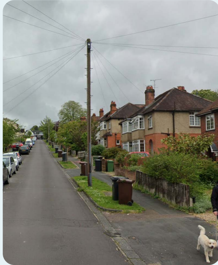
Kabels in alle richtingen verspreid vanaf één mast Winchester, Engeland
