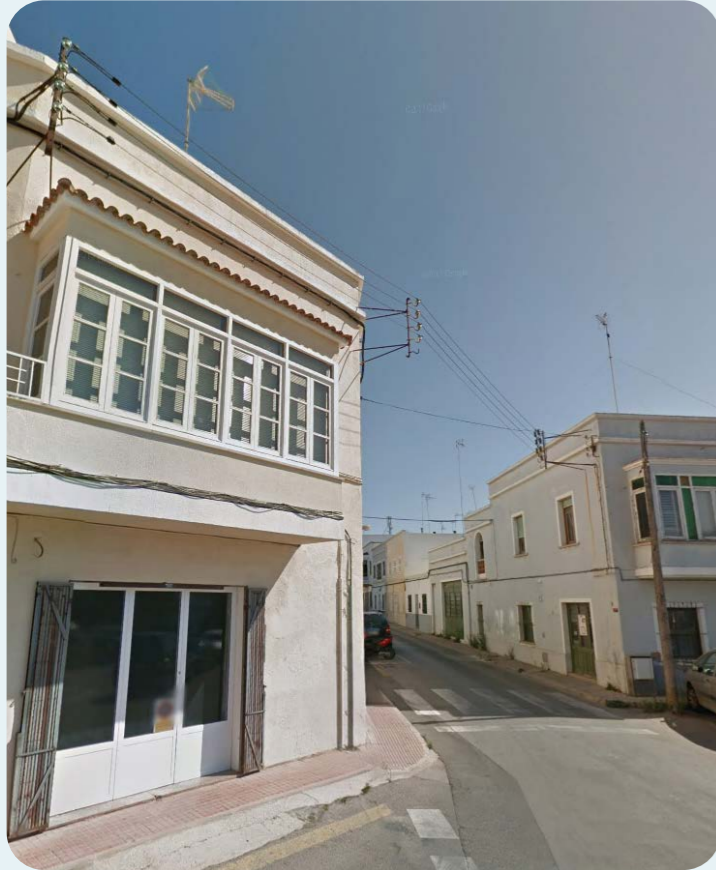
Kabels op verschillende manieren aan de gevel bevestigd Menorca, Spanje
