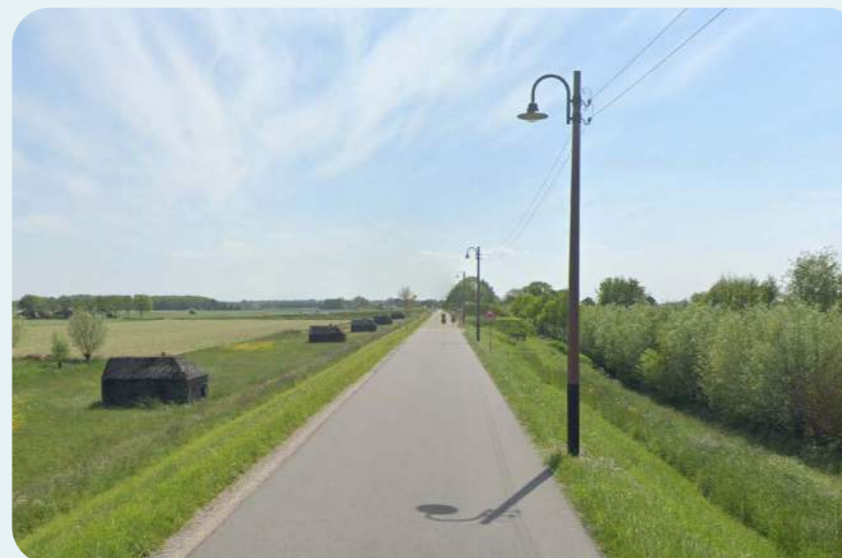
Bovengrondse laagspanning, gecombineerd met straatverlichting Diefdijk, Nederland
