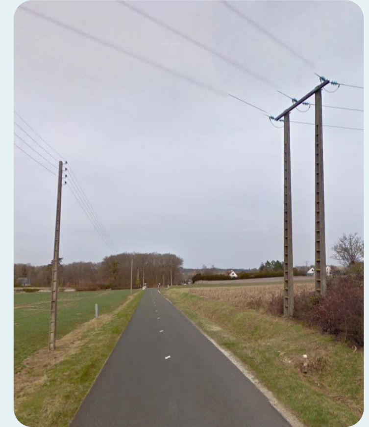
Midden- en laagspanning bovengronds Valloire-sur-Cisse, Frankrijk
