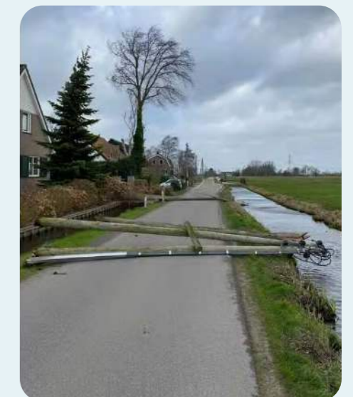
Een omgewaaide bokpaal na een flinke storm in de Krimpenerwaard
